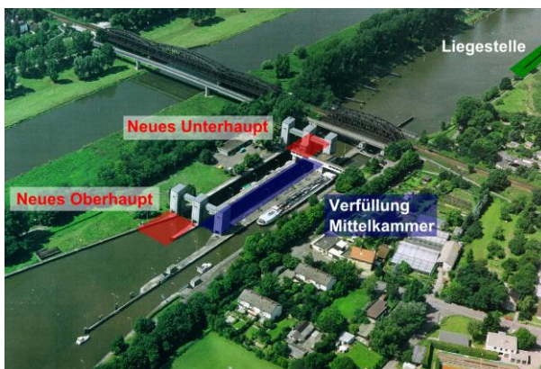
Bild 1 Ansicht des Projektfeldes
